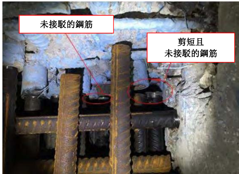
圖 3-2 第157號不合格報告中的工地照片 - 採取糾正措施之前的EM100牆板 (資料來源：《全面評估報告》圖7)
