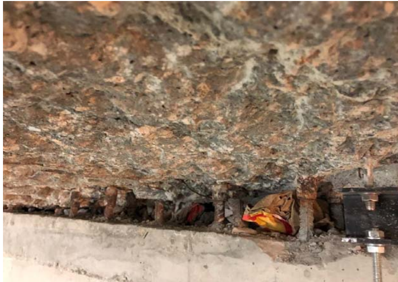
圖 3-6 東西走廊層板與支柱之間的縫隙
